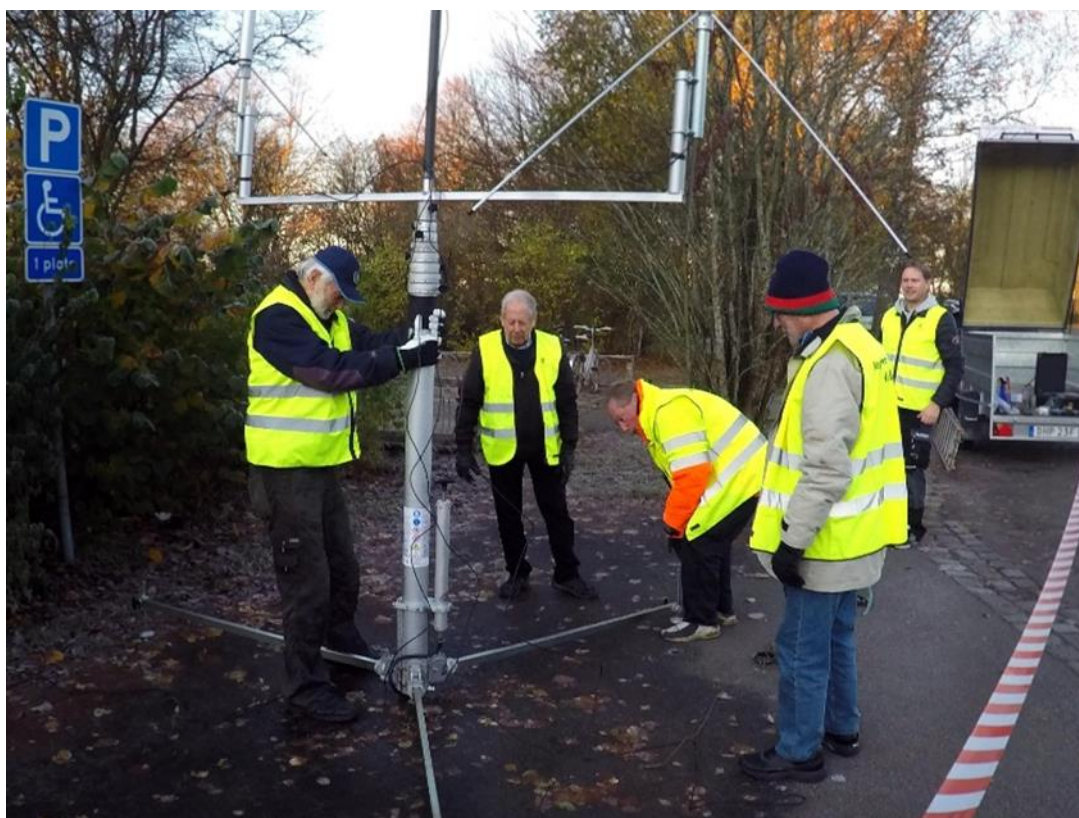
Första upprättande av pneumatisk mast, grupparbete. Masten tillhör Länsstyrelsen N-län Foto: Bilduppdrag Varberg, Lennart Benson
